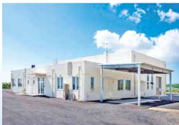
水処理施設（完成）
