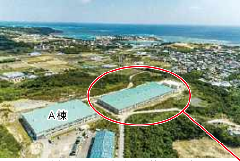
美らグリーン南城（最終処分場）
