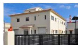
汚泥再生処理センター（東部）
