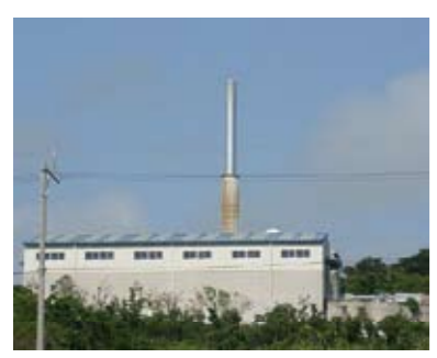
平成26年3月に閉鎖し、最終処分場建設工事が進められる島尻消防清掃組合の島尻環境美化センター
