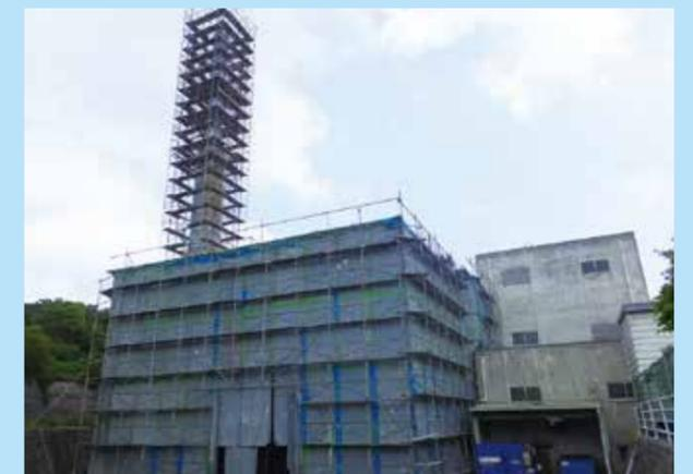
解体工事中は粉塵の飛散、騒音を抑制するため、建物外周に解体用の枠組み足場等を設置し、シート養生を施します。また、一部の工事については機械により内部気圧を負圧にして粉塵等が外へ流出するのを防ぎます。
