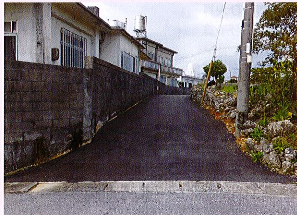
集落道路アスファルト舗装
