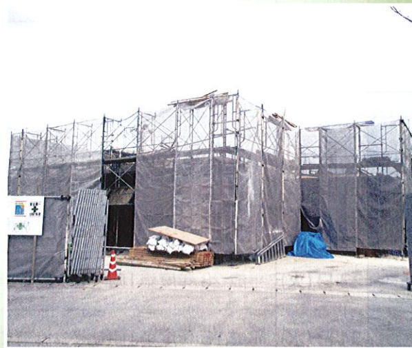
工事中写真（H 28.9.1 撮影）
