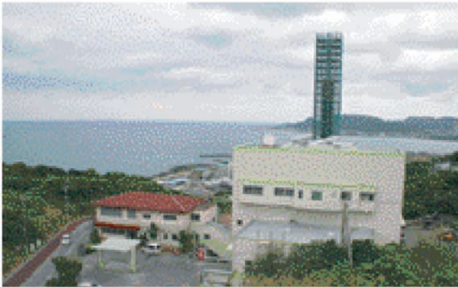
基幹改良後の稼働を待つ東部清掃施設組合清掃工場
