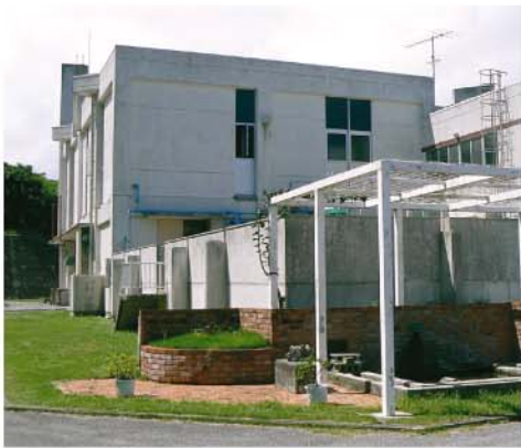
築20年の清澄苑し尿処理施設
