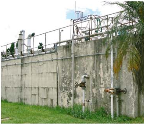
築33年が経過し、老朽化が著しい東部清掃施設組合の西原処理場
