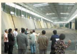
宮崎県クリーンコアたかさき (被覆型最終処分場)
