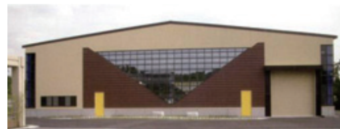
宮崎県都城市高崎一般廃棄物最終処分場外観
